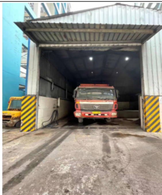
石子煤转运站
