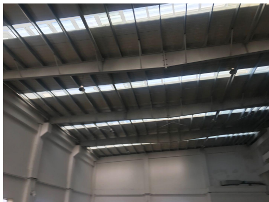
垃圾卸料大厅密闭
